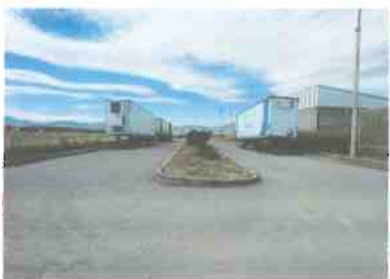
Acceso a Inmueble
